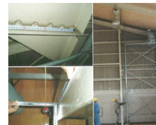
建物の耐震調査診断 と補強提案
